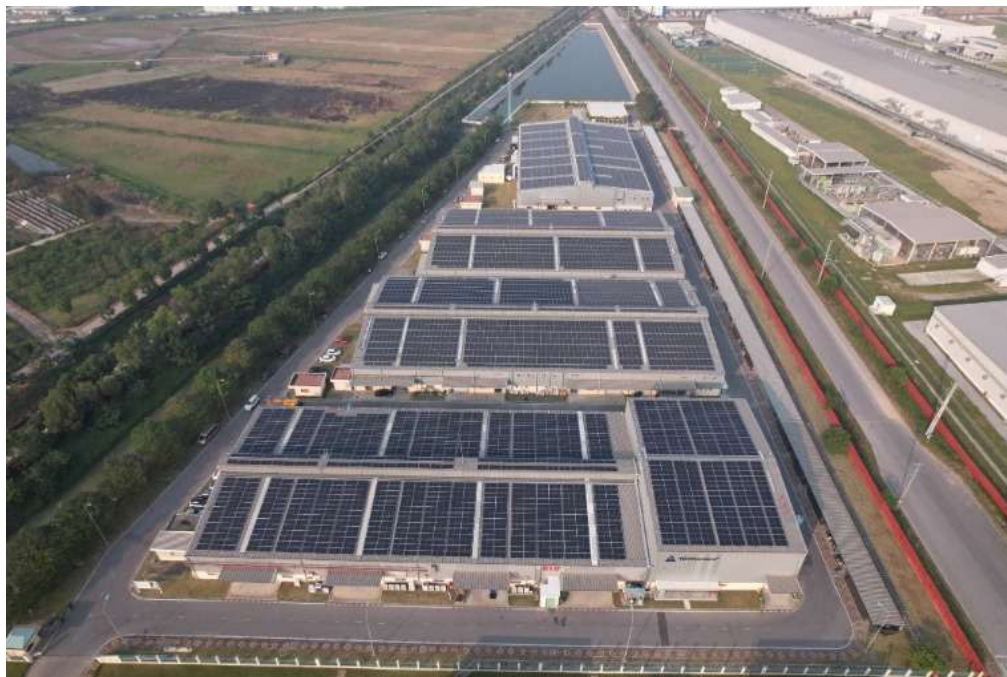
Hình 4-1: Dự án điện mặt trời áp mái tại Ban quản lý Khu công nghiệp Thăng Long II
