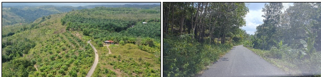
Gambar 30. Bagian dari jalan internal yang dapat ditingkatkan di daerah perbukitan (kiri); beberapa bagian sudah diaspal dan sebagian besar lebarnya ~4 m (kanan). Jalan harus diperlebar, terutama di bagian yang berkelok-kelok.
