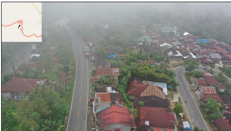
Gambar 20. Tikungan tajam di jalan di Sialogo, Tapanuli Selatan karena turunan jalan di ketinggian yang curam
