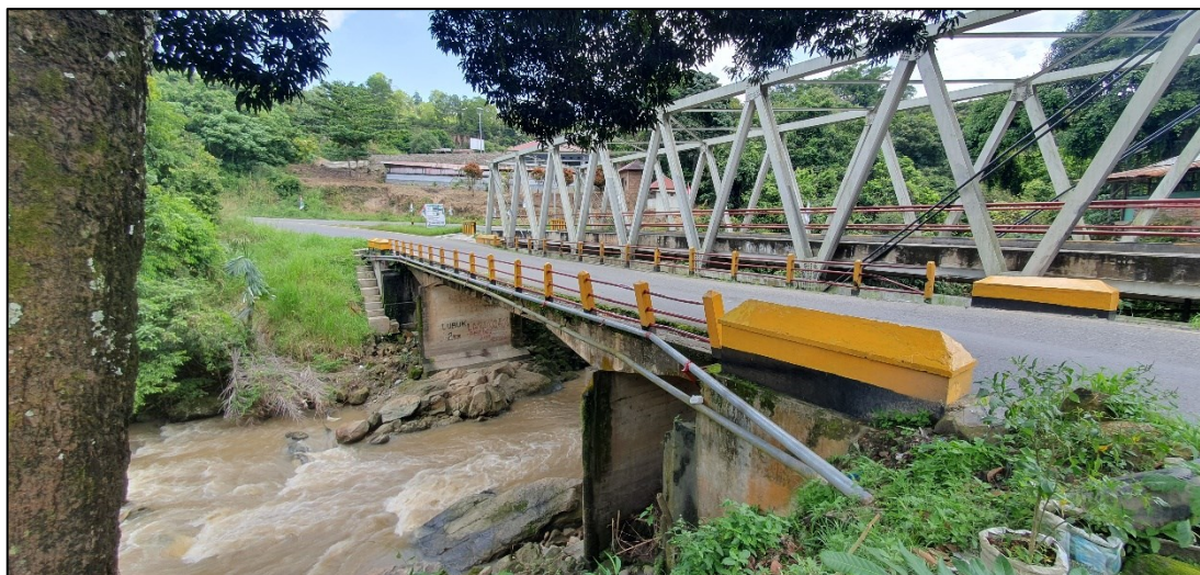
Gambar 26. Sebuah perlintasan di dekat Bandara Aek Godang memiliki jembatan beton tua dan jembatan baja baru.
