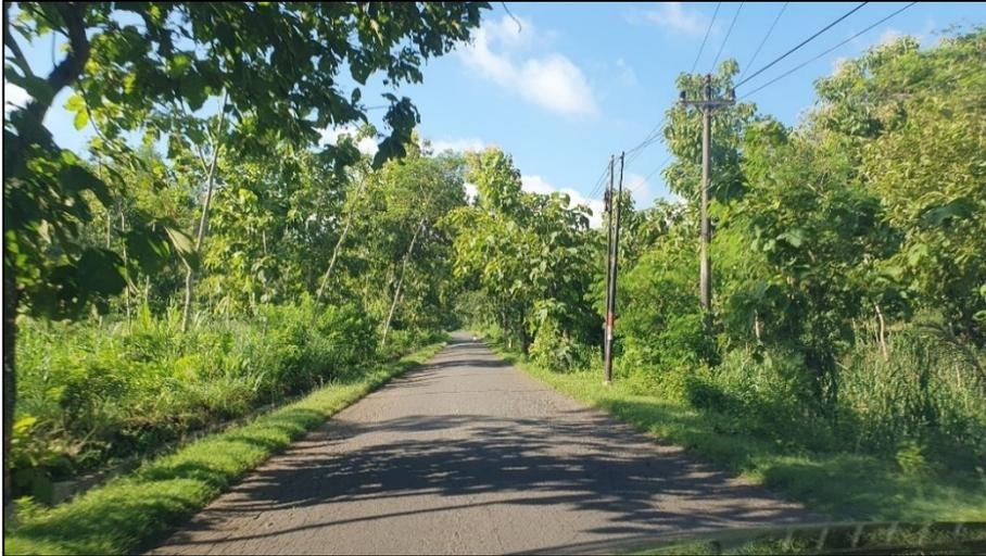
Gambar 24. Jalan yang menghubungkan Semanu dengan desa-desa di dalam lokasi. Jalan harus dibersihkan dari pohon/dahan yang menjuntai dan di tikungan mungkin diperlukan pelebaran. Diperkirakan setelah konstruksi, seluruh jalan perlu diaspal karena angkutan yang berat.
