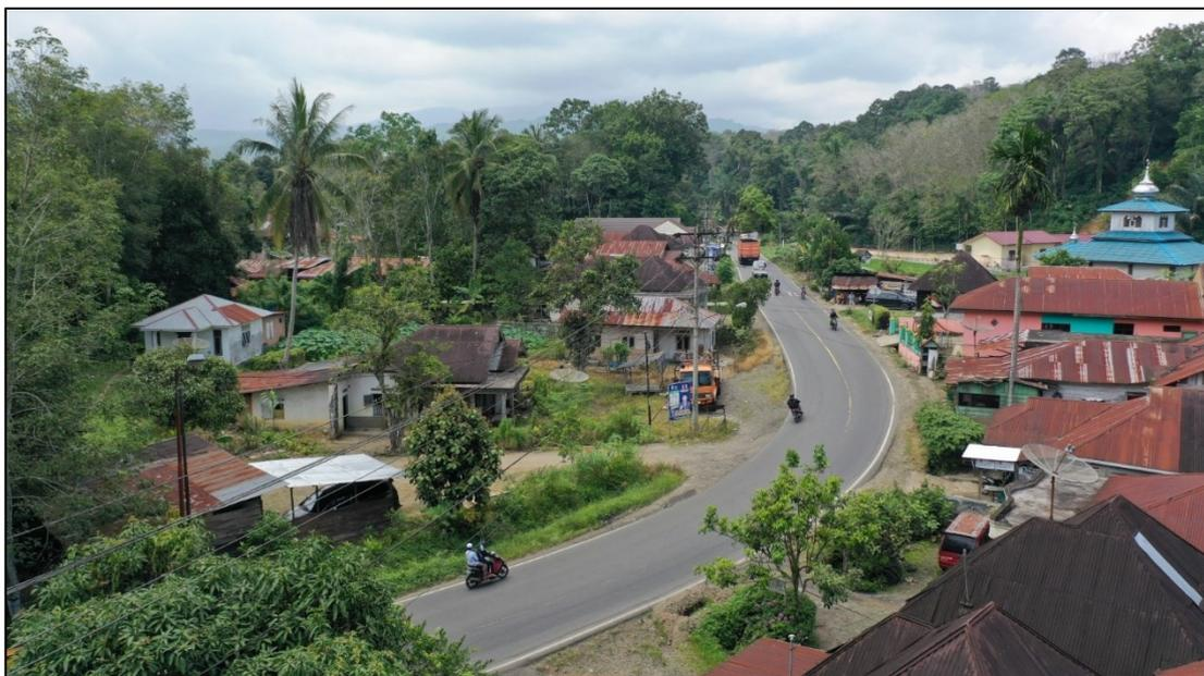
Gambar 13. Tata letak jalan khas di pedesaan Indonesia. Jalan berliku selebar ~ 6 hingga 7 m melayani lalu lintas lokal, regional, dan nasional. Kabel listrik udara dan telekomunikasi dengan tiang di kedua sisi jalan. Bangunan-bangunan berada dalam jarak yang dekat. Di dalam kota dan kota yang lebih besar, jalan pada umumnya sedikit lebih lebar, namun dengan lebih banyak kabel udara, tiang, dan papan reklame.
