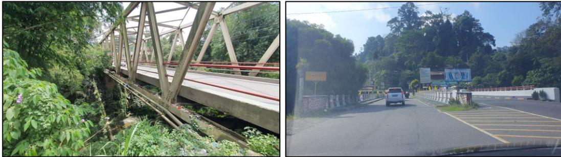
Gambar 22. Contoh jembatan baja (kiri) dan jembatan beton (kanan)
