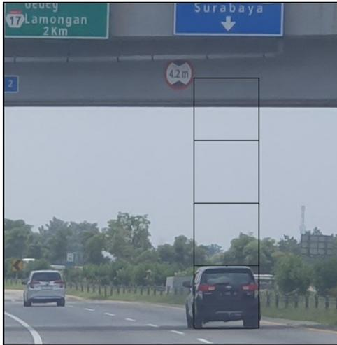
Gambar 16. Ketinggian jembatan di atas permukaan jalan tampak lebih dari 4,2 m. Sebagai perbandingan, tinggi Toyota Innova Reborn ini sesuai spesifikasinya adalah 1.795 m.
