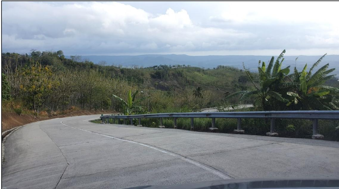
Gambar 24. Contoh jalan di rute C. Pada bagian curam seperti ini, bahu jalan juga diaspal.
