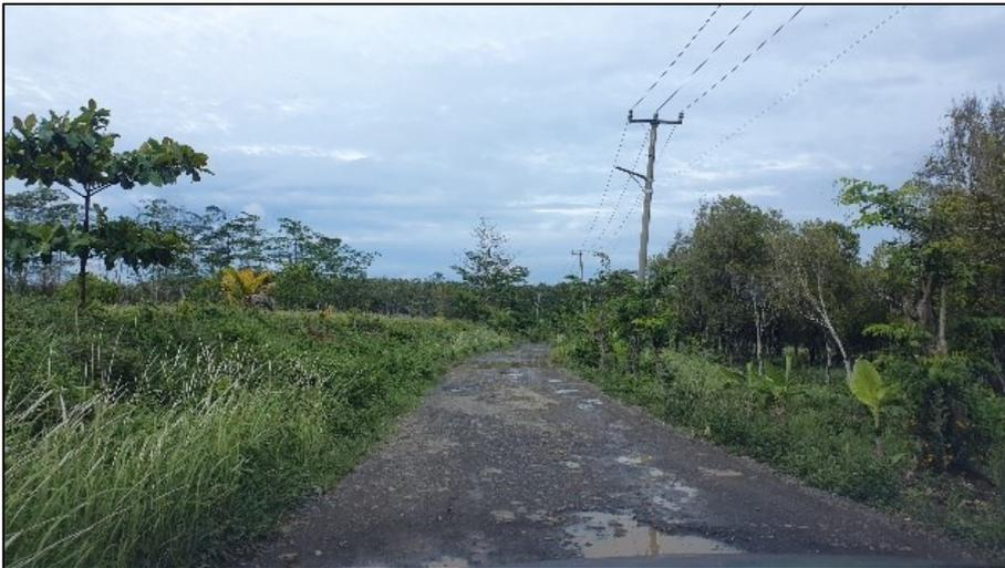
Gambar 28. Contoh jalan yang tidak terawat dengan baik.
