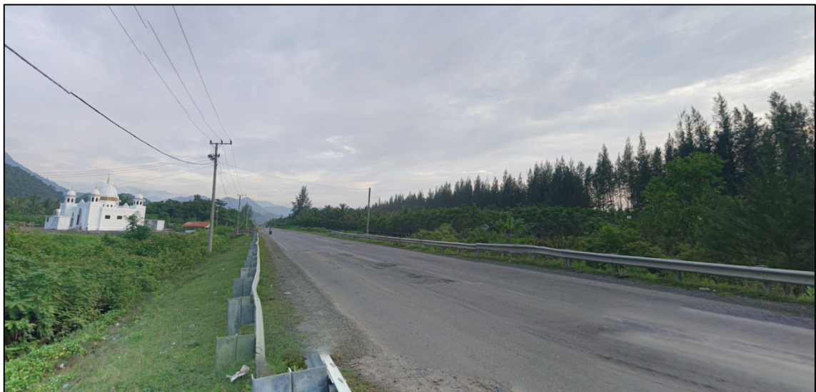
Gambar 19. Jalan nasional di Banda Aceh yang dekat dengan lokasi proyek. Jalan melengkung lebar dan berkelok-kelok dengan lebar ~ 6 hingga 7 m yang melayani lalu lintas lokal, regional, dan nasional. Kabel listrik dan telekomunikasi udara dengan tiang di kedua sisi jalan.
