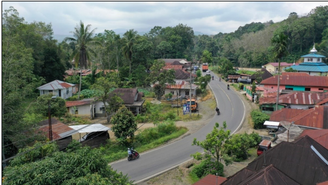
Gambar 14. Tata letak jalan khas di pedesaan Indonesia. Jalan berliku selebar ~ 6 hingga 7 m melayani lalu lintas lokal, regional, dan nasional. Kabel listrik udara dan telekomunikasi dengan tiang di kedua sisi jalan. Bangunan-bangunan berada dalam jarak yang dekat. Di dalam kota dan kota yang lebih besar, jalan pada umumnya sedikit lebih lebar, namun dengan lebih banyak kabel udara, tiang, dan papan reklame.
