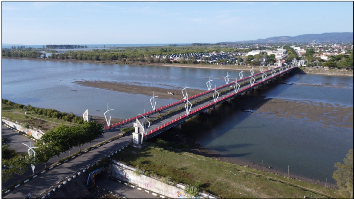
Gambar 18. Jembatan Krueng Cut di Banda Aceh.
